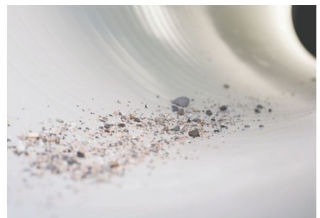
Pared interior de la tubería orange.
