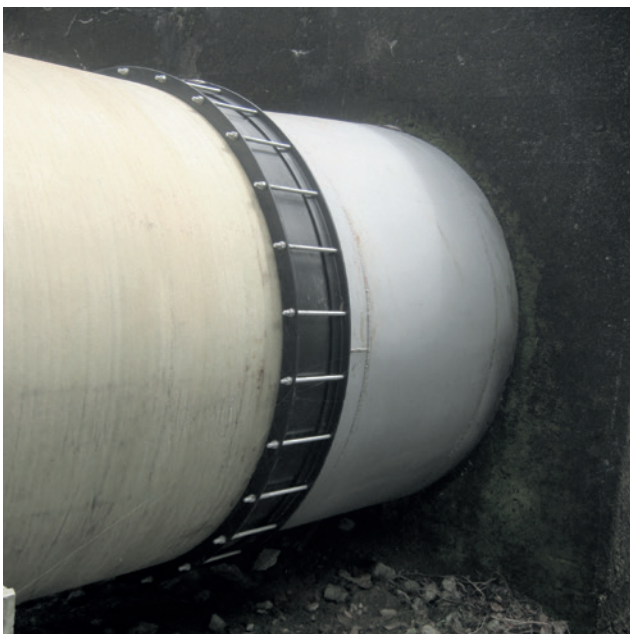
Figura 8. Unión mecánica rígida.
