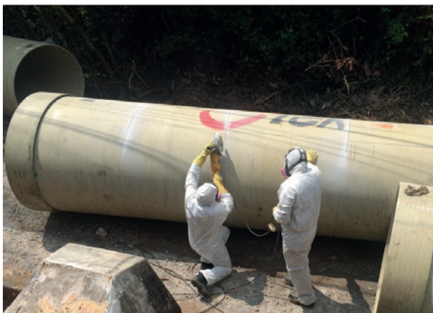
Figura 2. Corte de tubería.
