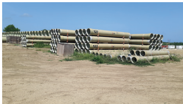
Figura 19. Almacenamiento en obra de tuberías GRP/PRFV.
