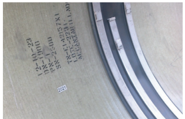
Figura 12. Unión mecánica para reparación interna.
